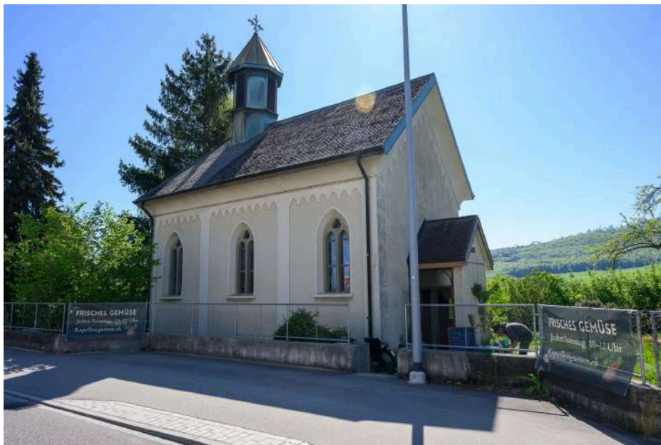
Larkins Plan: Die Kapelle soll an Samstagen zum Markt und Dorftreffpunkt werden. Bild: Bruno Kissling
